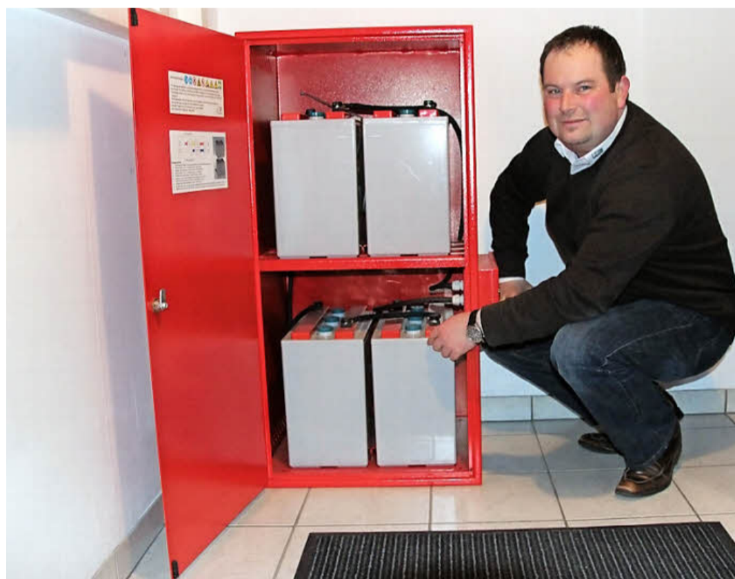
Michael Greif hat die Tür geöffnet, damit man das Innenleben sehen kann. In diesem roten Schrank sind die Batterien untergebracht, in denen der Strom gespeichert wird.
